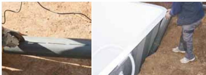
Mise en place du puisard ou drain
