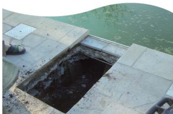
6 - Fin des gros travaux
